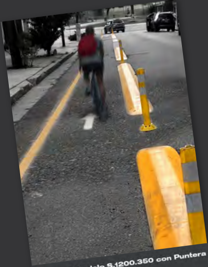
Separador de vías Modelo S.1200.350 con Puntera Av. Cabildo - Ciudad de Buenos Aires Medidas del módulo: Largo 1,20m - Ancho 35cm - Altura 7cm Divide las calles de Metrobus del tránsito de vehículos particulares
