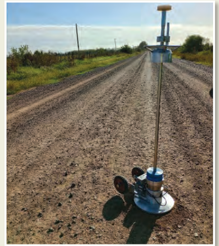
Figura 9. Control de compactación con LWD de la capa estabilizada
