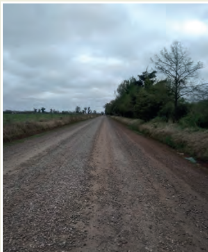
Figura 4. Camino rural estabilizado con Conaid + riego de P.P.
