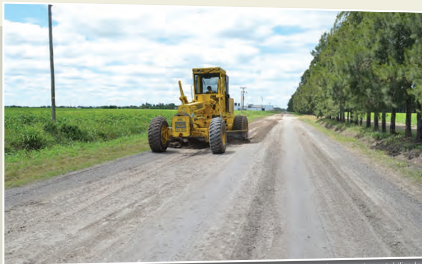
Figura 7. - Mantenimiento de un camino estabilizado
