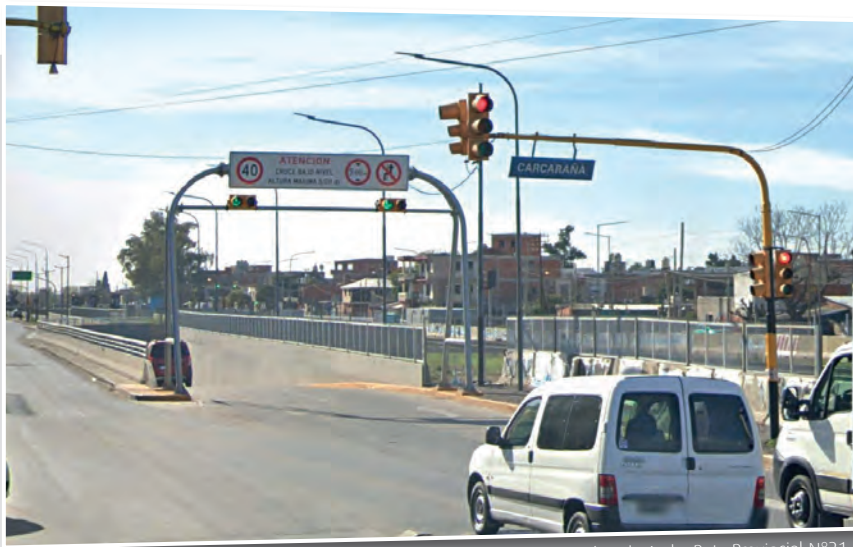
Figura 3. Fotografía del acceso al túnel de Carcarañá en la Avda. Ruta Provincial N°21.
