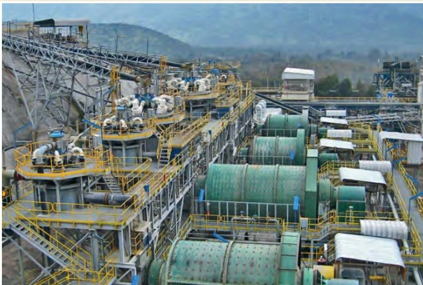
Circuitos cerrados de molienda y plantas de concentración gravimétrica: etapas de molienda, concentración y deslamado.
