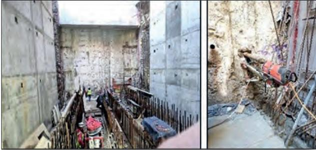
Figura 22. Extracción de testigos horizontales en el perímetro de la abertura.
