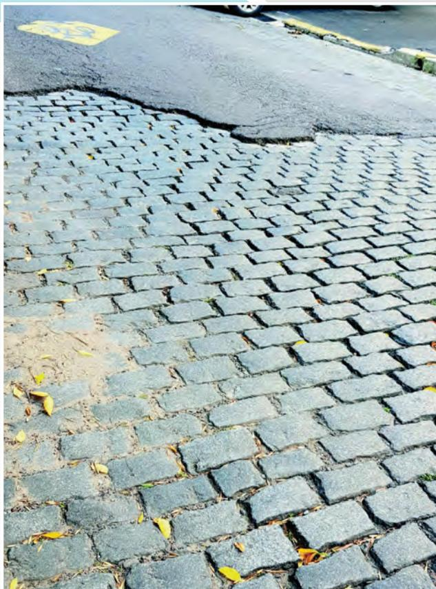
**Figura 3.** Vistas parciales del pavimento de adoquines previo a la ejecución de la obra de remodelación.
