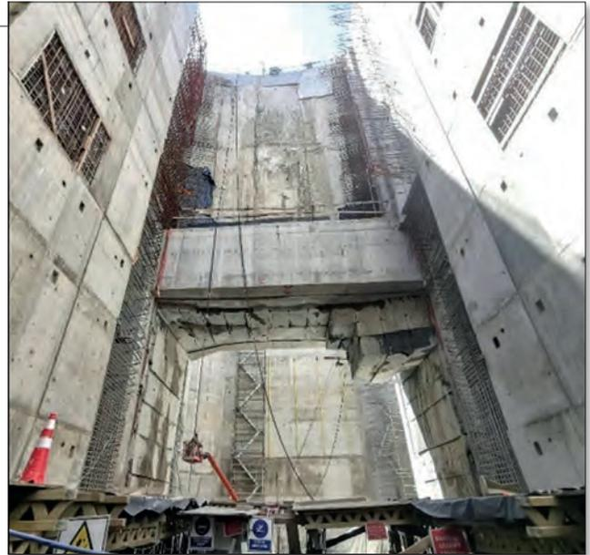
Figura 24. Demolición de la abertura al 95% de avance.
