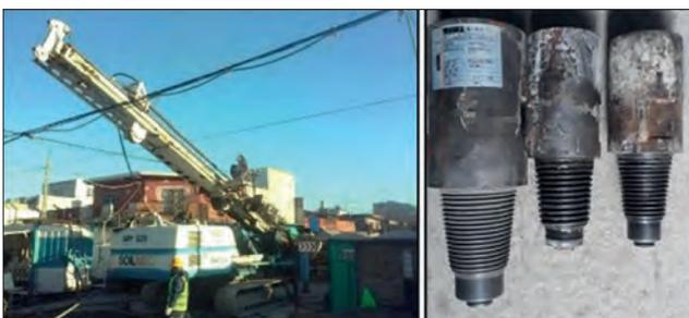
Figura 15. Equipo perforador y monitores empleados. Fuente: Pilotes Trevi.
