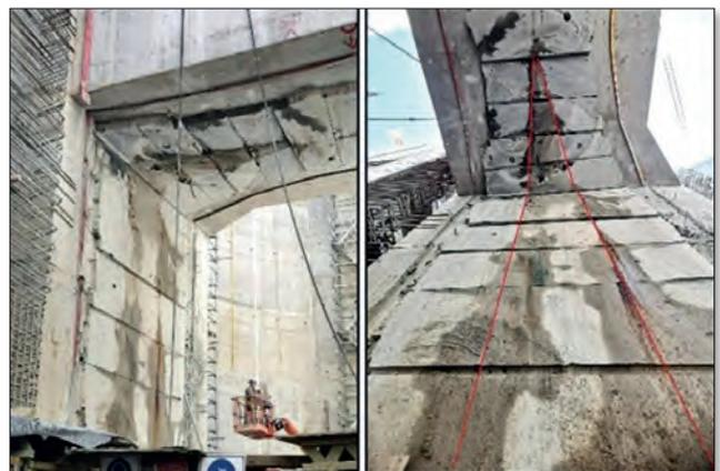
Figura 25. Filtraciones de agua menores en el contacto muro - Jet Grouting (línea roja sobreimpresa).
