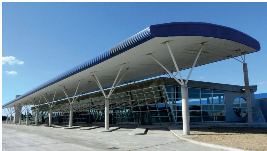
La nueva terminal de Junín, ubicada en Av. De Circunvalación y Ruta Nacional 7.
