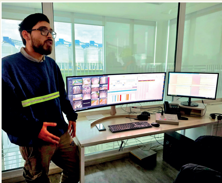
Centro de control de carga de los cereales a los barcos.
