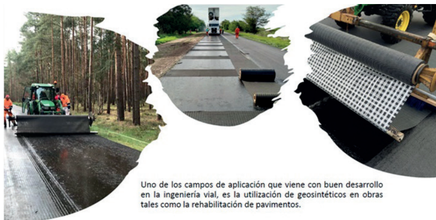
Figura 1. Geosintético en una rehabilitación de pavimento
