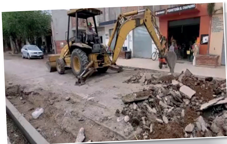
Demolición de carpeta asfáltica
