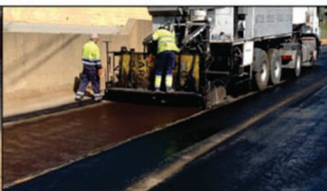
CAPA DE RODADURA SLURRY
