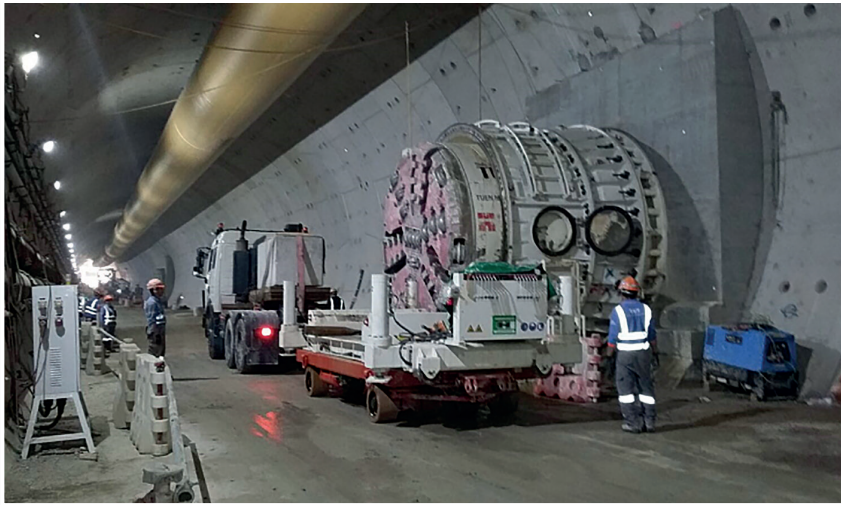
Figura 5: Recuperación de la AVN 3000 en el túnel, después del avance en la campaña de recepción. Criterios de diseño para pasos superiores
